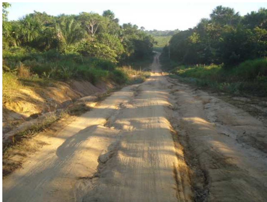
Foto 22 - Vista da estrada e entrada de acesso ao TI Puyanawa
